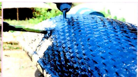
Sơn phủ nhựa đường để chống thấm nước
