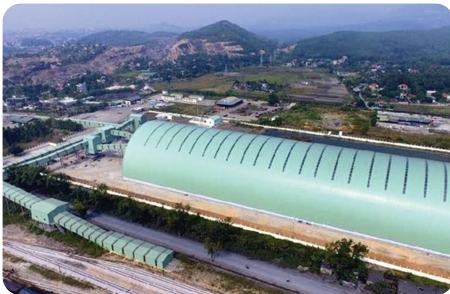
Hình 12.5. Khu nhà chứa và tuyến băng tải vận chuyển than Khe Ngát – cảng Điện Công
