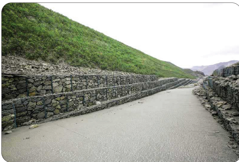
Hình 12.4. Hệ thống đập chắn đất, đá tại chân các bãi thải mỏ ngăn ngừa tình trạng sạt lở đất tại bãi thải Đông Cao Sơn
